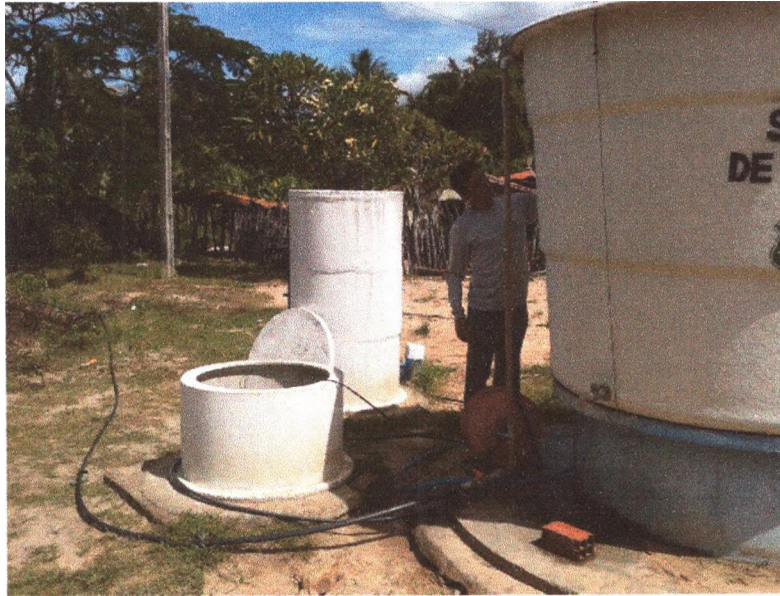
Preparando a estrutura para iniciar o teste de bombeamento (bombeamento volumétrico).
